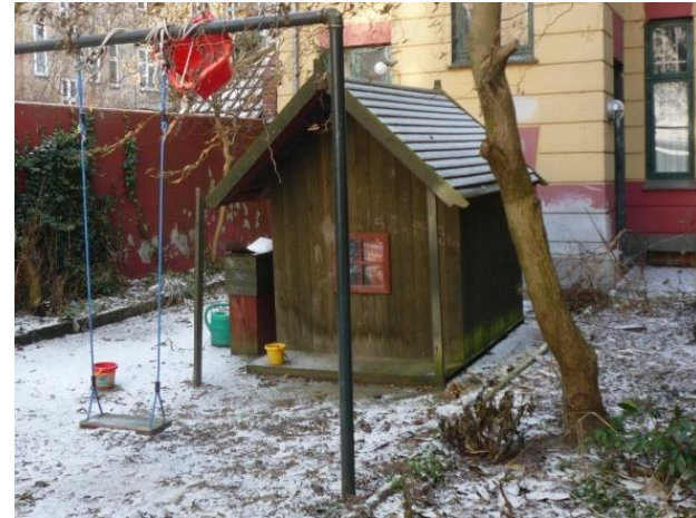
Eksisterende legehus istandsættes
