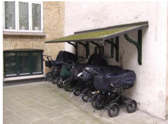
Halvtag på mur
