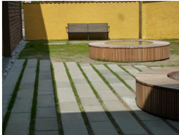
Betonfliser med græsfuger
